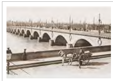
Pont de Pierre des années 1920 - Bordeaux REF. 2-0015
